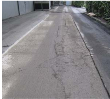
写真-3 ②エリアの切削後状況
