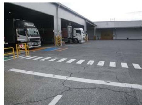
写真-5 施工前状況
