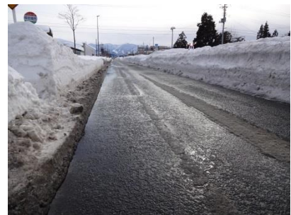
写真-3 市街地の路線の施工前の状況 工区③
