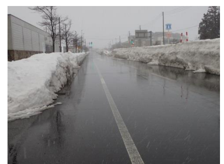
写真-9 施工1年後の状況(工区③)
