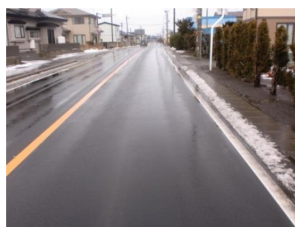
写真-8 施工半年後の状況(工区②)
