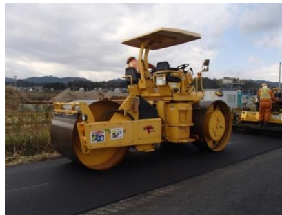
写真-5 施工状況
