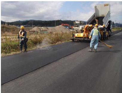
写真-4 施工状況
