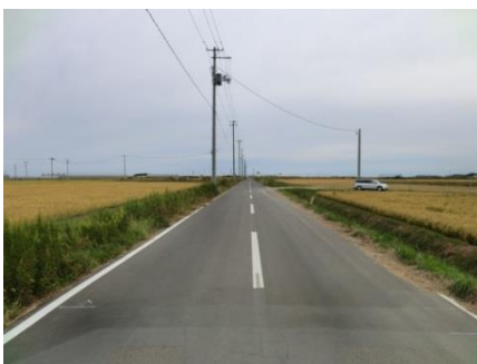
写真-7 施工1年後の状況(工区①)
