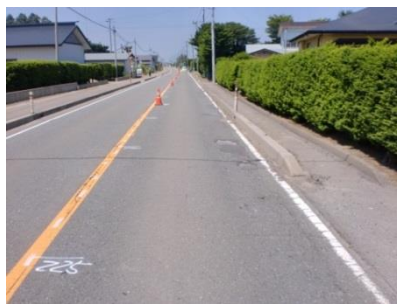
写真-2 住宅街の路線の施工前の状況 工区②
