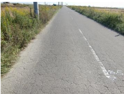
写真-1 水田近くの路線の施工前の状況 工区①
