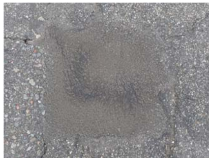
写真-7 微細クラック（A材）
