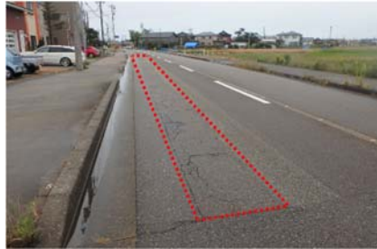
写真-4 試験施工箇所
