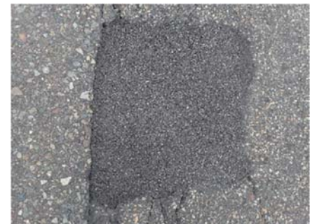
写真-8 細粒分の飛散（I材）
