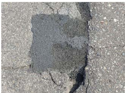
写真-6 骨材飛散（C材）
