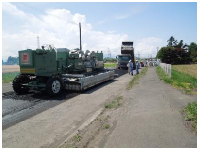
写真-3 施工状況
