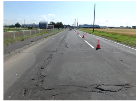
写真-2 施工前の路面状況
