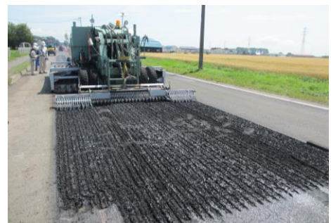
写真-1 加熱および掻きほぐしの状況
