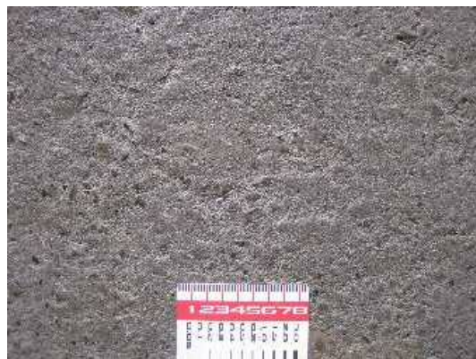
写真-6 転圧後の舗装表面の状態
