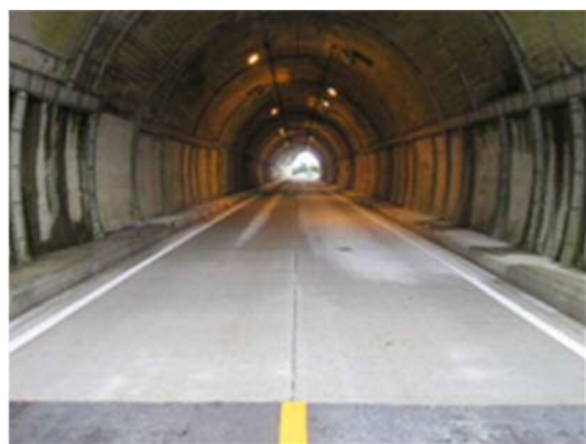
写真-7 完成後のトンネル外観
