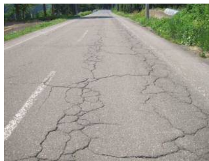
写真-5 施工前状況
