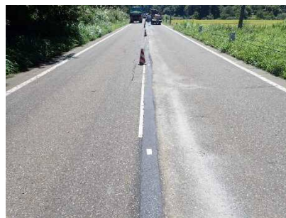
写真-10 施工後状況
