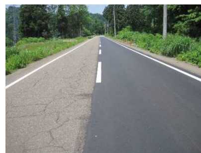
写真-6 施工後状況
