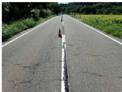
写真-9 施工前状況
