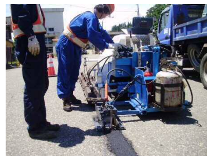
写真-8 施工状況
