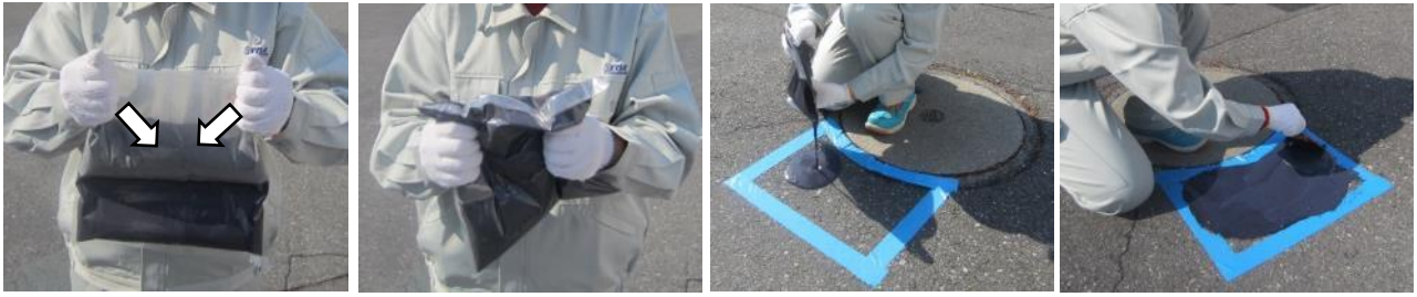
写真-2 施工状況 (左から、混合前、混合中、混合物の排出、敷きならし状況)
