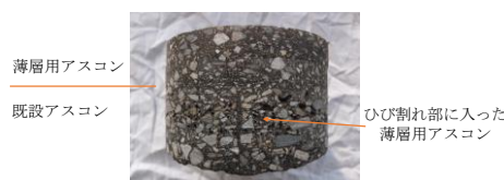
写真-2 ひび割れ充填状況
