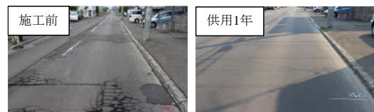
写真-1 薄層用アスコンの施工例
