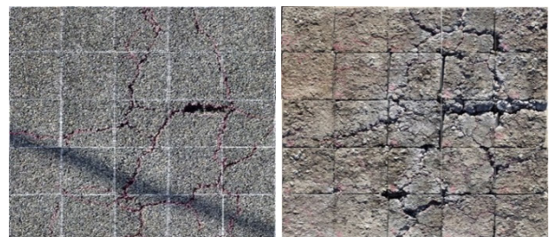
写真-2 同一ブロックの舗装路面と上層路盤下面のひび割れ状況
