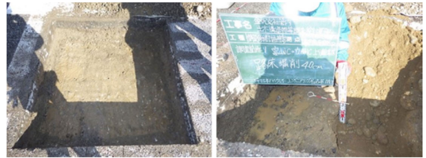
写真-5 上部路床上面の開削断面と上部路床材の掘削断面の状況
