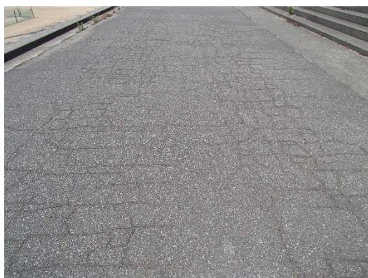
写真-3 現場Hの路面状況
