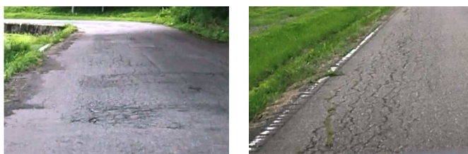
写真-2 現場路面状況 (左：区間 A、右：区間 B)
