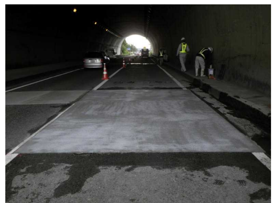
写真－７ コンクリート打設完了②
