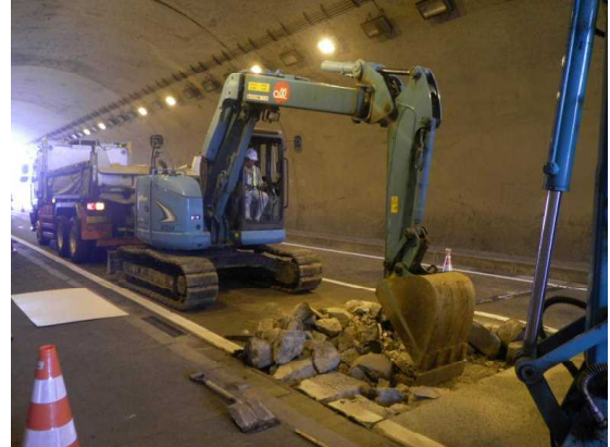
写真－４ 舗装版破砕
