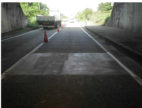
写真－６ コンクリート打設完了①
