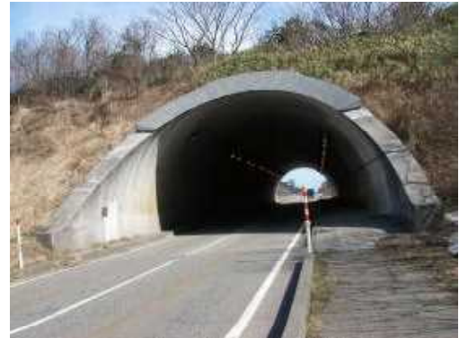
写真－1 八幡林トンネル
