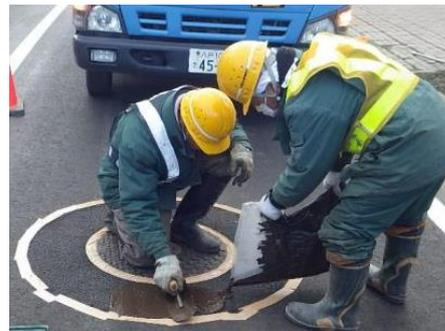
写真-3 開発品によるマンホール段差補修
