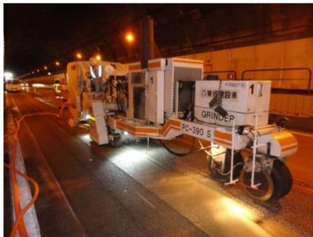
図6 ダイヤモンドグライディング工法(DG)
