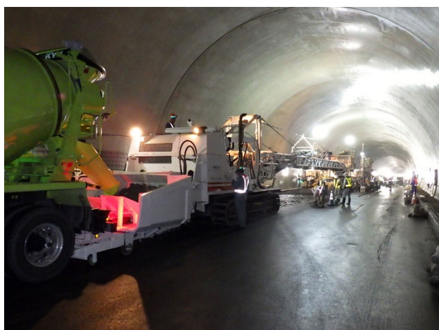
写真-4 縦取機のコンクリート供給状況
