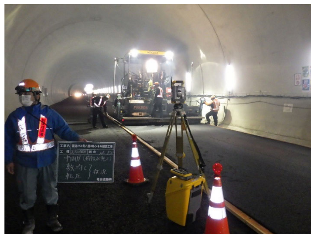
写真-3 情報化施工を活用した中間層施工状況
