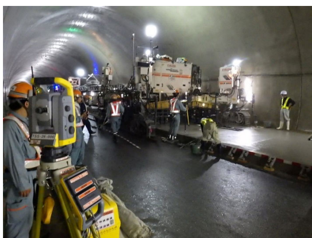
写真-6 情報化施工を活用したコンクリート舗装
