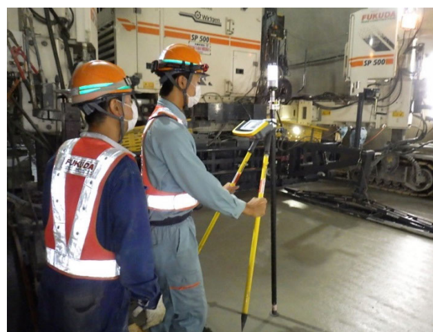
写真-7 コンクリート舗装直後の仕上り確認
