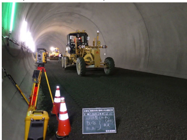
写真-2 情報化施工を活用した上層路盤施工状況
