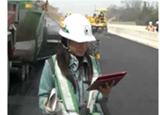
写真 - 6 タブレットでの状況確認
