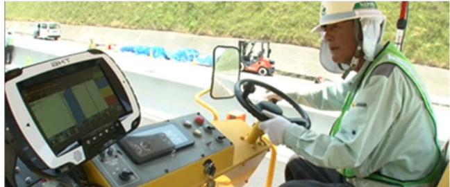
写真 - 7 次世代転圧管理システム
