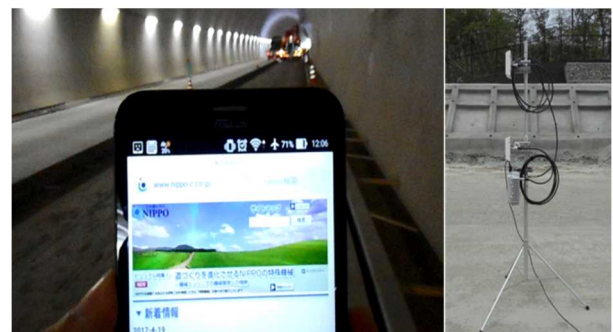
写真 - 1 トンネル内における Wi-Fi 環境構築状況
