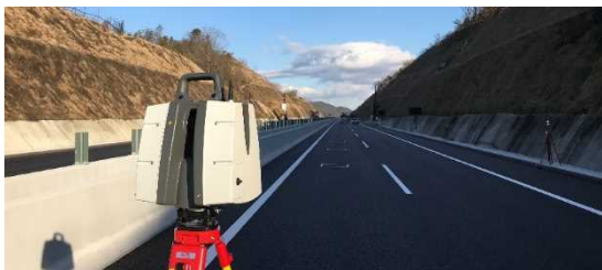
写真-1 TLS 計測状況
