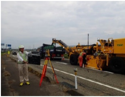
写真-6 情報化施工施工状況
