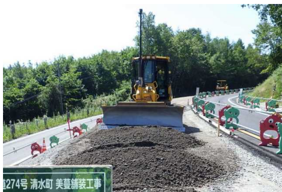
写真-1 3DMC ブルドーザによる施工状況
