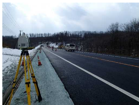
写真-5 TLS による表層工の出来形測定状況
