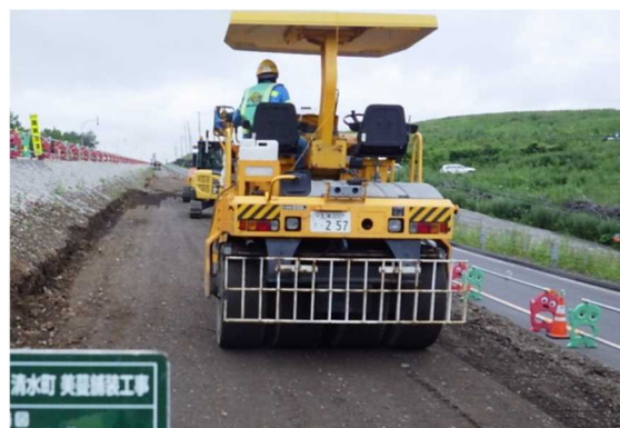
写真-2 転圧管理システムによる施工状況
