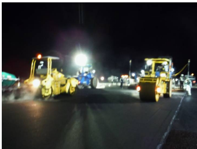
写真-4 施工状況
