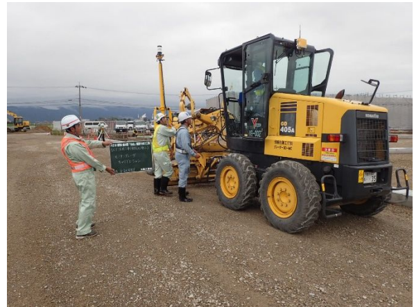
写真-4 ICT グレーダ キャリブレーション状況
