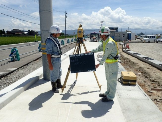
写真-1 精度検証状況
