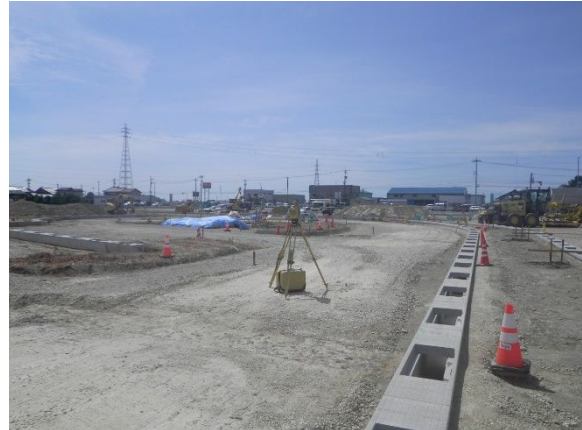
写真-2 計測状況
