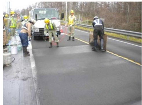
写真-2 吹き付け状況
