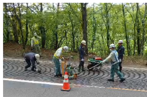
写真-10 施工状況
