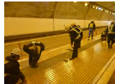
写真-1 養生状況
