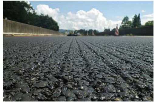
図-5 凍結抑制舗装（粗面系）
