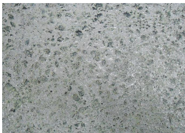
写真-1 目標とする仕上がり表面 1)
