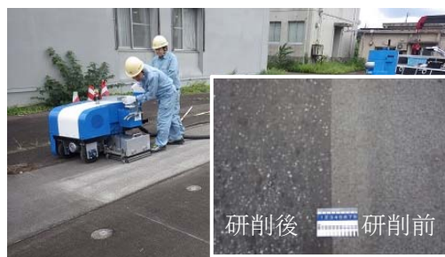
写真-5 研削状況および研削路面状況
