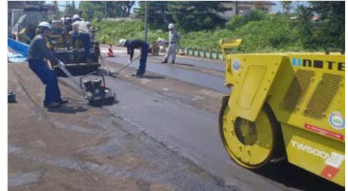
写真-3 施工状況
