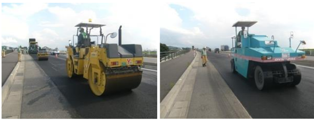
写真-4 初期・二次転圧 写真-5 仕上げ転圧
