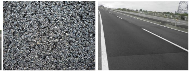
写真-6 舗装表面 写真-7 舗装全景
