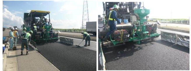
写真-2 敷きならし 写真-3 表面ゴム散布
