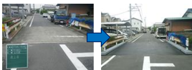
写真-2 施工前後の全景
