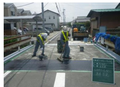
写真-1 CAMの敷きならし状況
