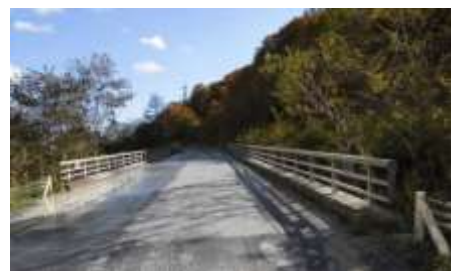
写真-1 宗山川 3 号橋の概観
