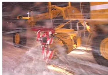
写真 2.1.1 除雪作業状況
