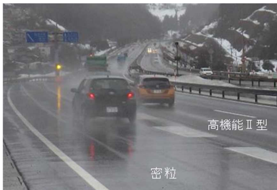
写真 6.1 水しぶきの状況
