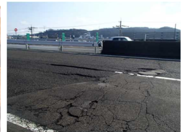
写真 2.1.2 路面損傷
