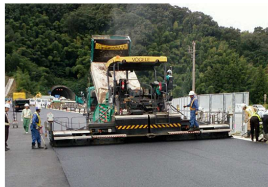
写真 5.2 表層の2車線同時施工
