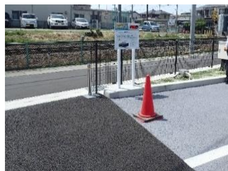
写真-2 遮熱性舗装
