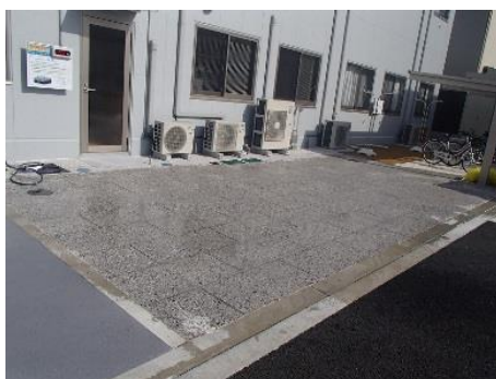
写真-1 保水性舗装
