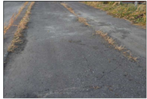
写真-1 既設歩道舗装
