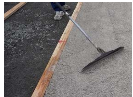
写真-3 敷きならし状況
