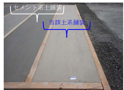
写真-4 施工完了状況
