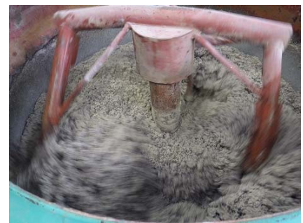
写真-2 混合状況
