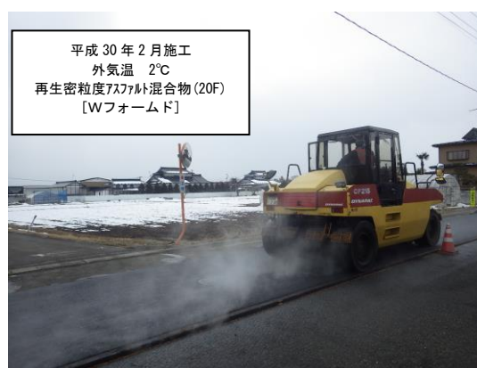
写真-1 施工状況
