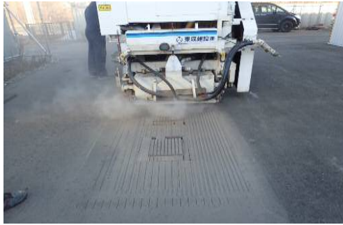
写真-1 グルーピング溝形成状況
