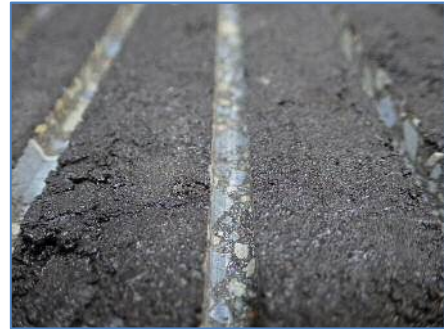
写真-2 グルーピング溝形成直後 (7日養生)
