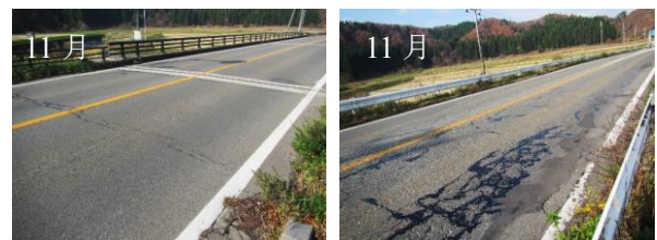
写真-2 測点①の現場状況 (280.60K.P)
