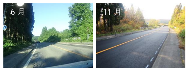
写真-3 測点②の現場状況 (286.76-287.03K.P)
