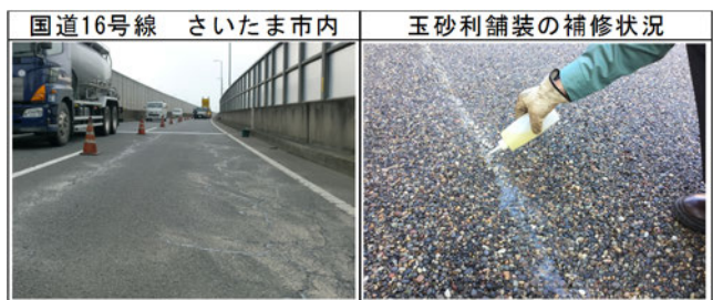
図-7 ひび割れ補修材の施工事例
