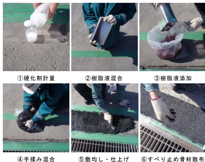
写真-6 開発品の施工手順
