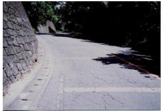
写真-4 施工前状況
