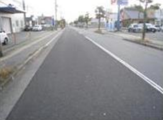
写真-7 施工6年後状況
