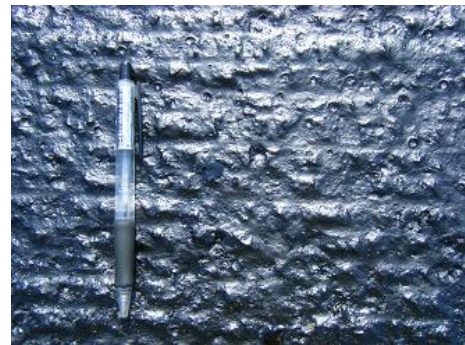
写真-2 ハイブローン SA 散布後 ( 0.8\text{l/m}^2 )
