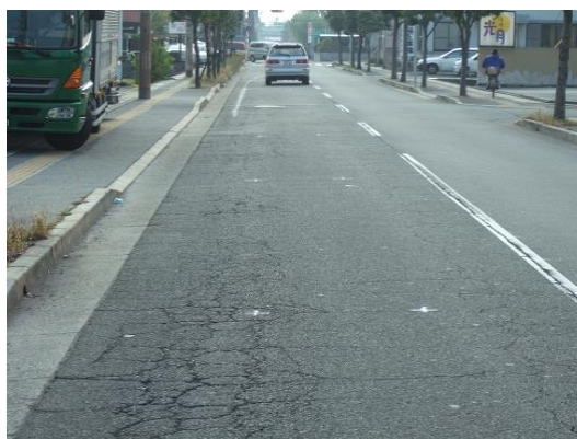
写真-6 施工前状況
