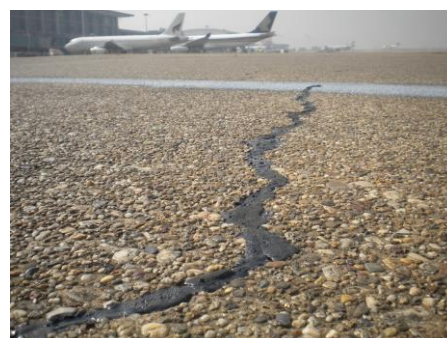
写真-6 施工後状況
