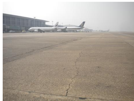
写真-4 施工前状況
