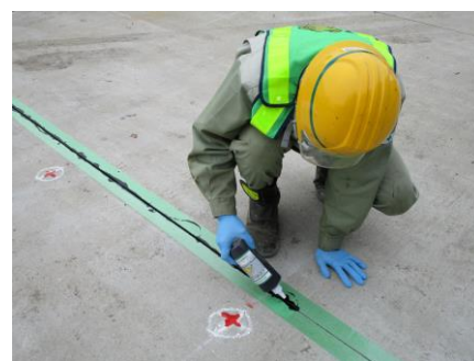
写真-2 シール材注入状況
