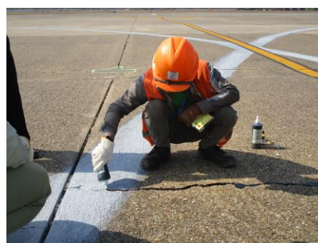
写真-5 施工状況
