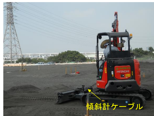
写真-9 現場での作業状況
