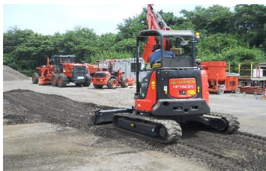
写真-1 ミニバックホウによる路盤の敷きならし状況
