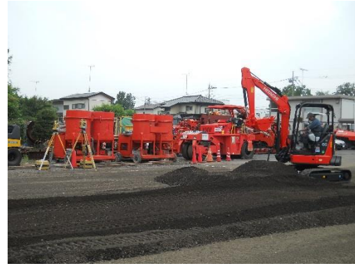
写真-8 試験施工状況
