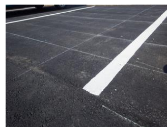
駐車場のライン補修
