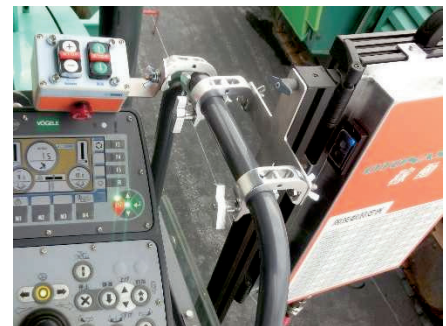
写真-4 LED パネル設置状況
