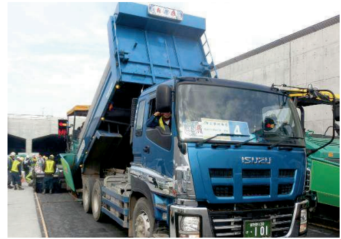
写真－1 合材受入れ状況
