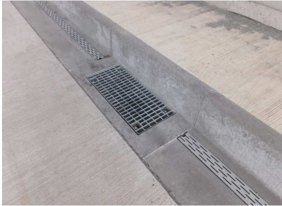
写真-2. 専用枡施工状況
