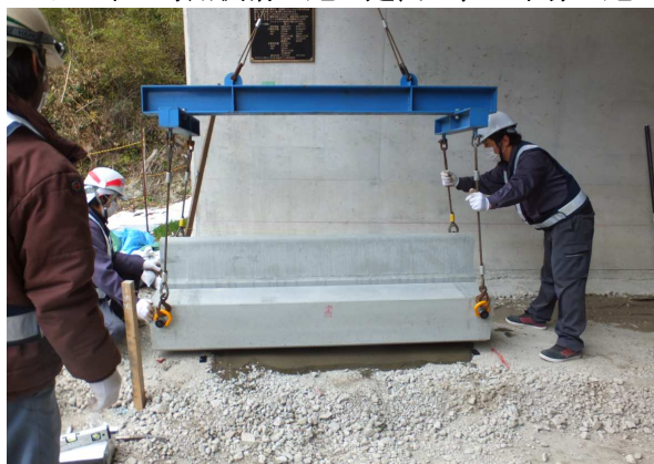
写真－6. 施工状況写真
