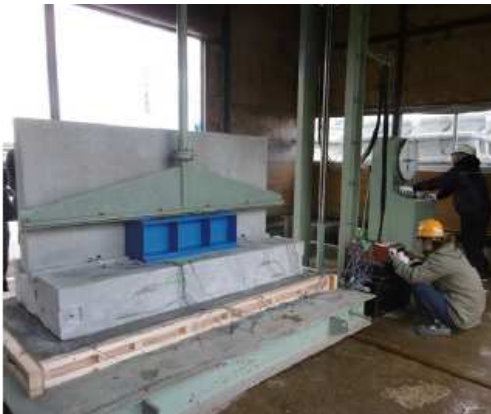
写真-9. 側溝部載荷試験状況
